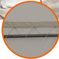
SYSTEM WIĄZANIA POSZYCIA DACHOWEGO
